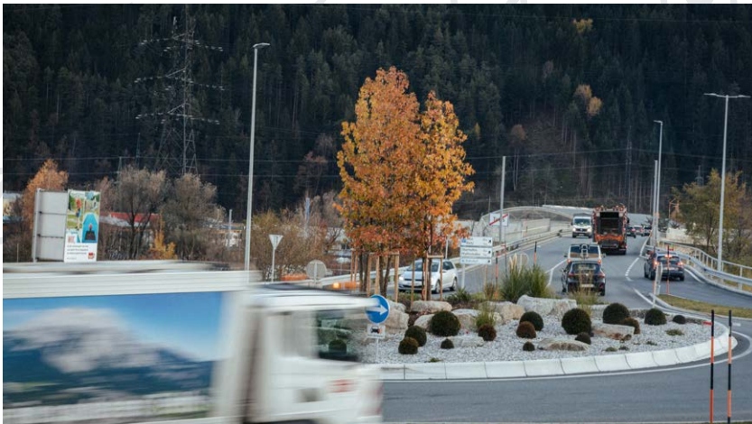
Der neue Kreisverkehr beim Sicherheitszentrum bringt verkehrstechnisch eine enorme Entlastung.
