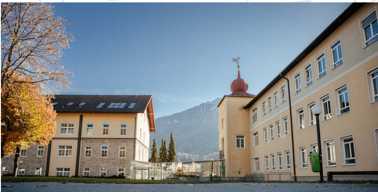
Einiges wurde in der VS Thielmann saniert bzw. erneuert, wie etwa die Elektrotechnik, WC-Anlagen oder ein Schallschutz in den Klassen. Zudem wurden die Klassen mit LED-Screens ausgestattet.
