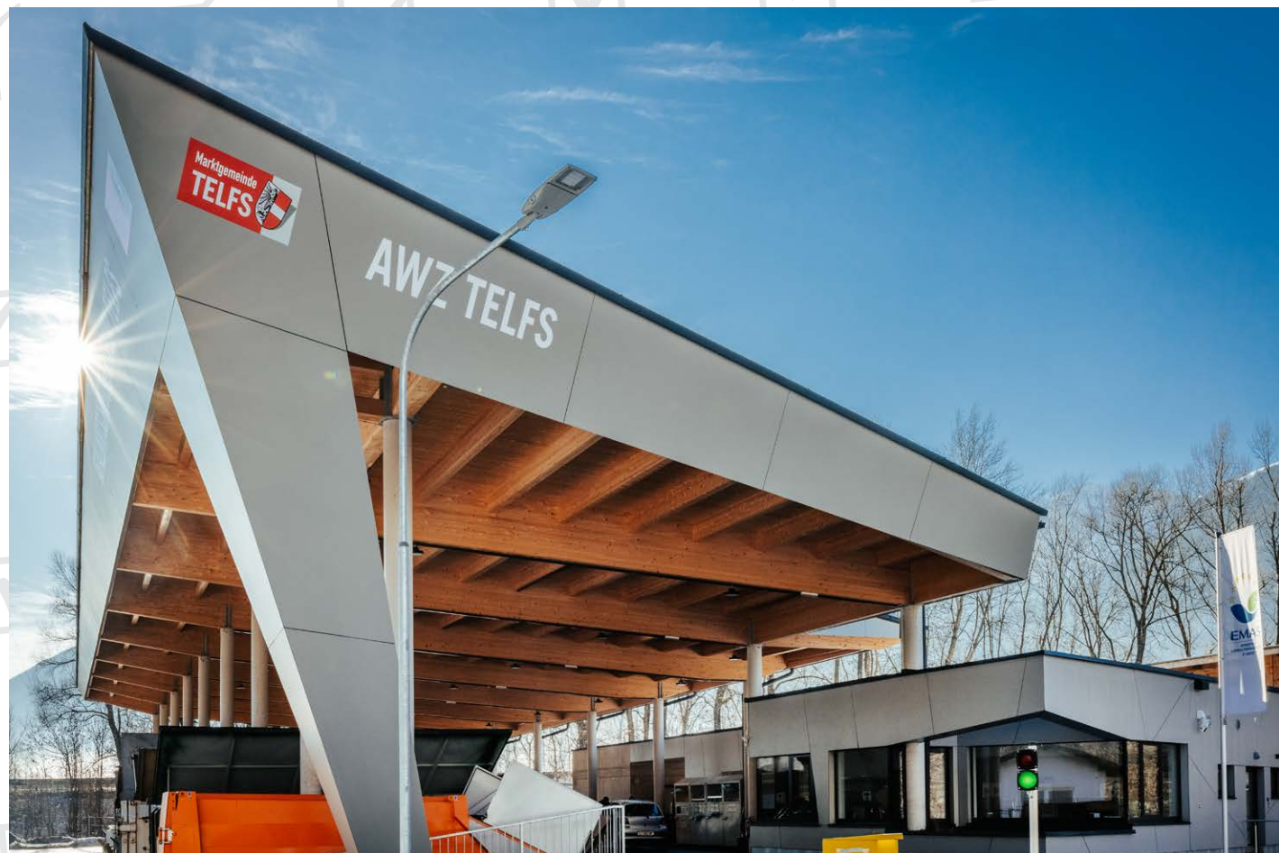
Das neue Abfallwirtschaftszentrum ist ein gemeindeübergreifendes Prestigeprojekt in Tirol.
