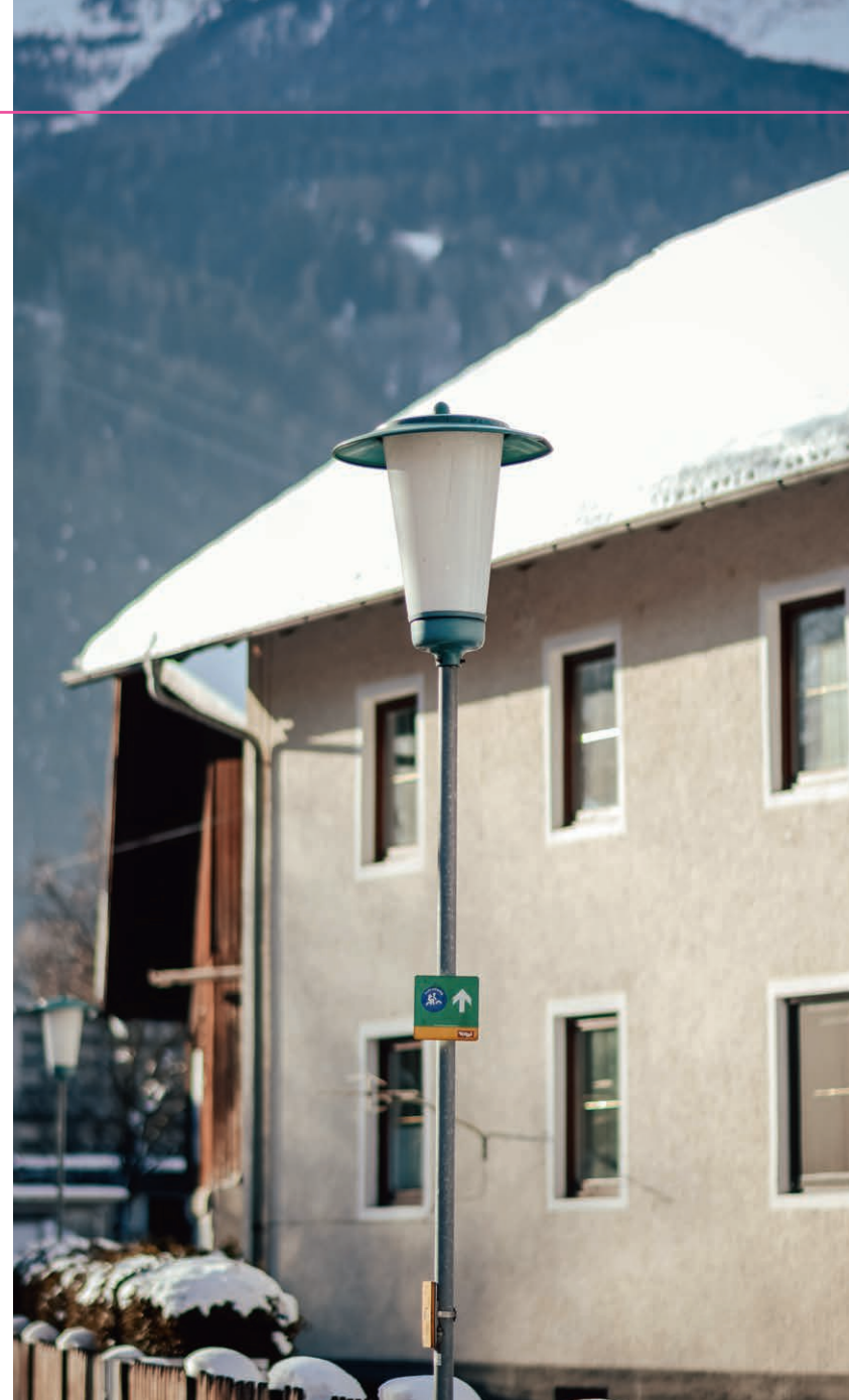
Diese alten Quecksilberlampen werden auf LED-Technologie umgerüstet.
