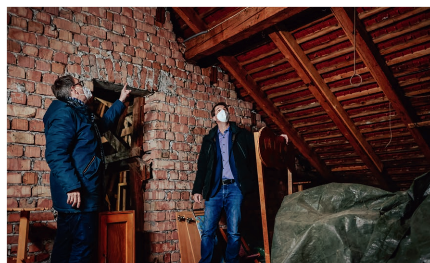
Bgm. Christian Härting und GR Klaus Schuchter bei der Besichtigung des sanierungsbedürftigen KG Markt.
